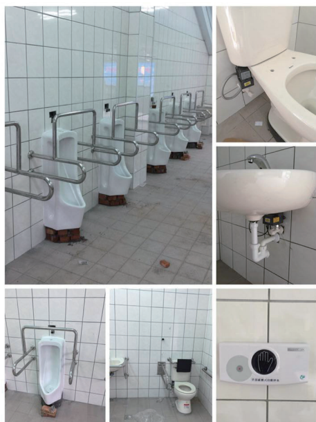
高雄輪椅夢公園無障礙設施非常完善
